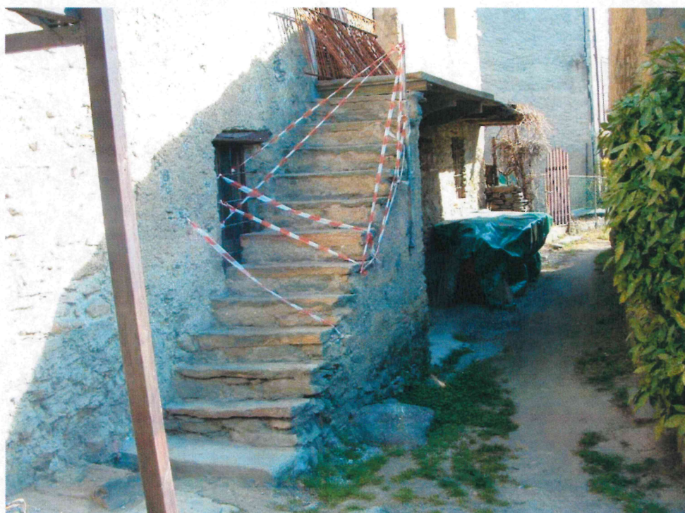
3) Fotografia a colori: dettaglio scala esterna in pietra
