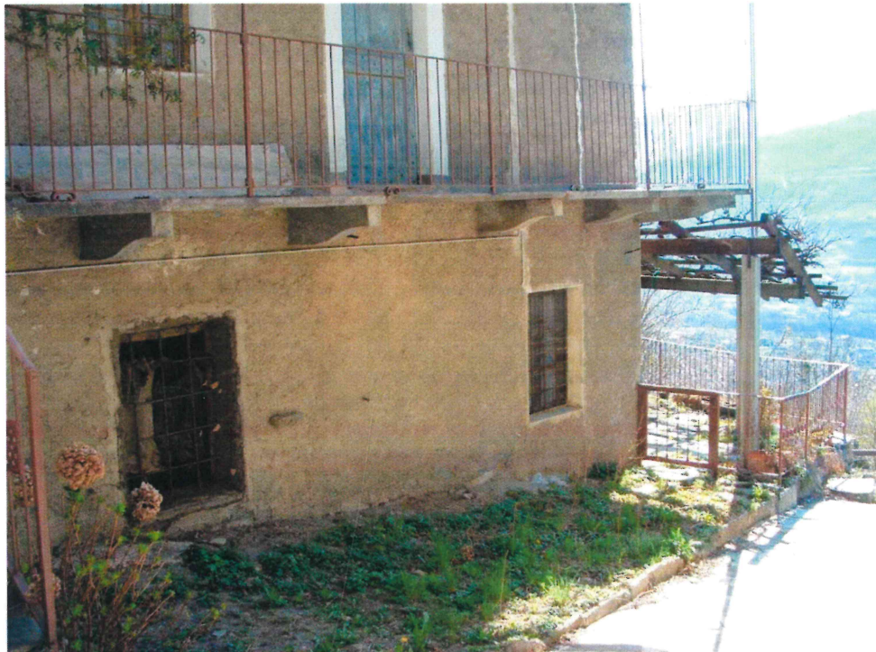
2) Fotografia a colori: dettaglio facciata, piano terra
